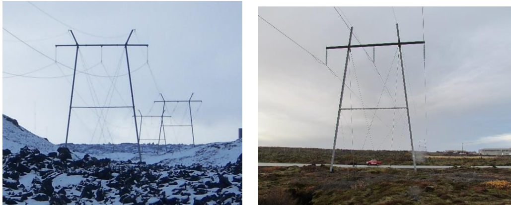
Mynd 2.5 220kV Rauðamelslína 1 t.v. og 132 kV Suðurnesjalína 1 til hægri
